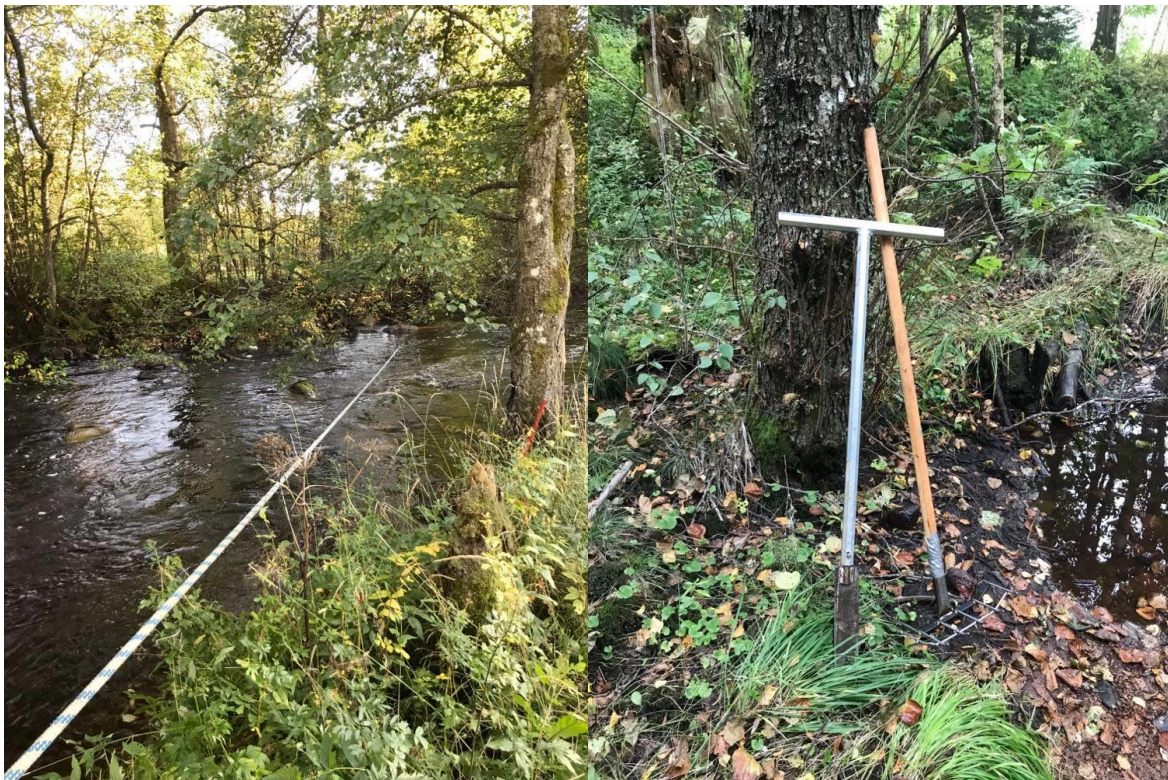
Figur 7. För att dra ut stora stenar i vattnet så användes vinsch, bild till vänster. Förutom att lägga tillbaka stenar i vattnet så luckrades bottenarna upp på vissa ställen med en metod som kallas Harti Jokki, bild till höger.
