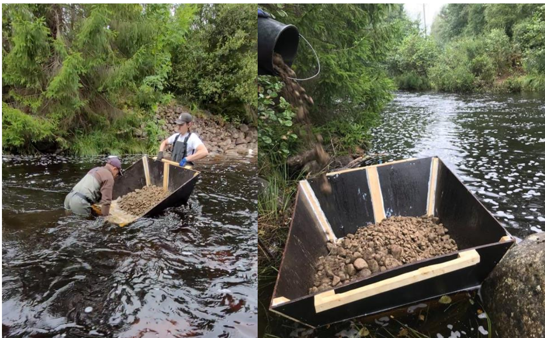
Figur 5. Förutom hjullastare så användes också en hemmagjord flotte för att få ut gruset till de platser som vi ville anlägga lekplatser på.
