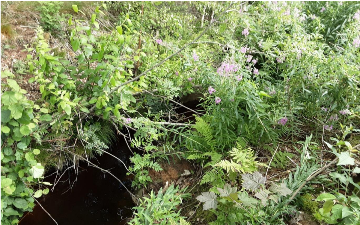
Figur 30. Vandringshinder 7 i västra grenen ,40 meter lång kulvert.
