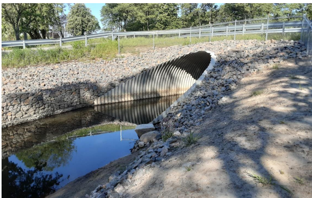
Figur 32. Första vägpasset i Vinån (nr 1), en rörbro under en allmän väg.
