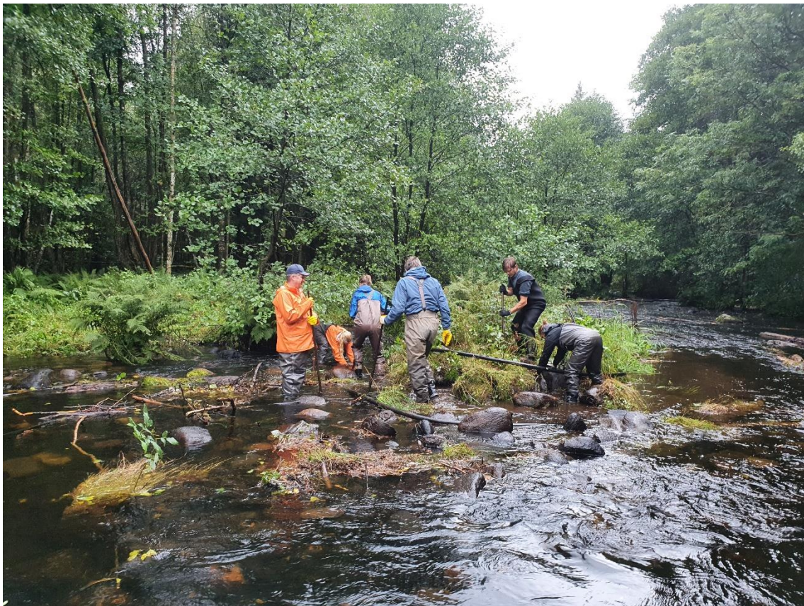
Figur 6. Uppbrytning av en ö i Sörån som bestod av rensmassor från tidigare rensningar.
