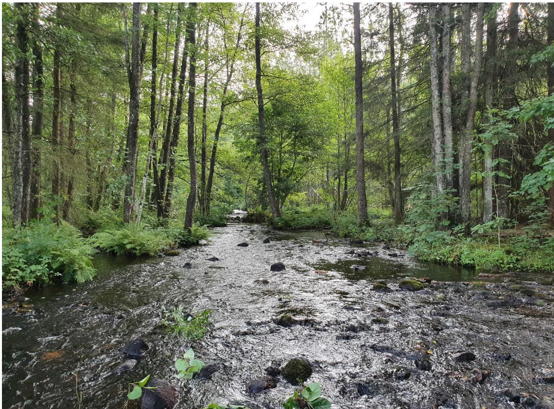
Figur 8. Samma sidofåra som ovan men efter åtgärd. Förutom att stenarna i mitten har brutits upp har även den styrarmen som finns i huvudfåran öppnats upp för att öka vattenflödet i sidofåror.
