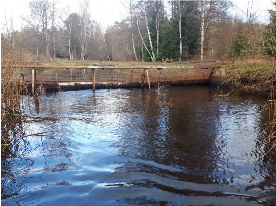
Figur 57. Galler över Mieån nedströms Norrefors fiskecamp. Foto: Jonathan Bark
