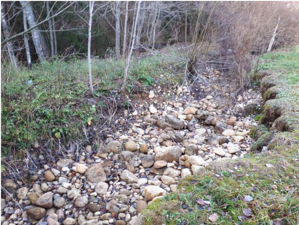
Figur 61. Omlöp utan vatten förbi Norrefors kvarn och såg i Mieån. Foto: Jonathan Bark
