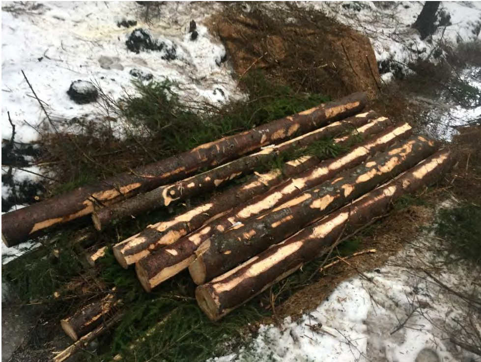
Figur 7. Material som används vid igenläggning av diken. Foto: Dan Calderon
