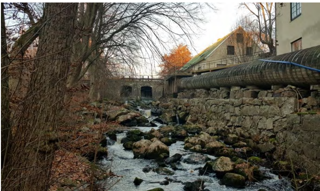
Figur 28. Spillfåra vid Strömma Bomullsspinneri i Mieån som kan torrläggas då kraftverket är igång och vatten går i tuben till höger i bild. Spillfåran är lämplig att använda som en del av fiskvägen. Foto: Johan Andersson.
