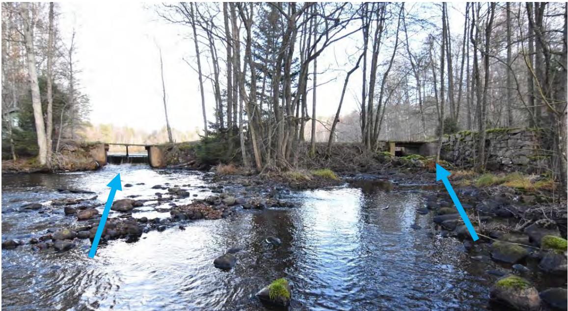
Figur 70. Dannemarks kvarn och såg i Mieån, sett nedifrån. Det finns två luckor (blåa pilar). Foto: Jonathan Bark
