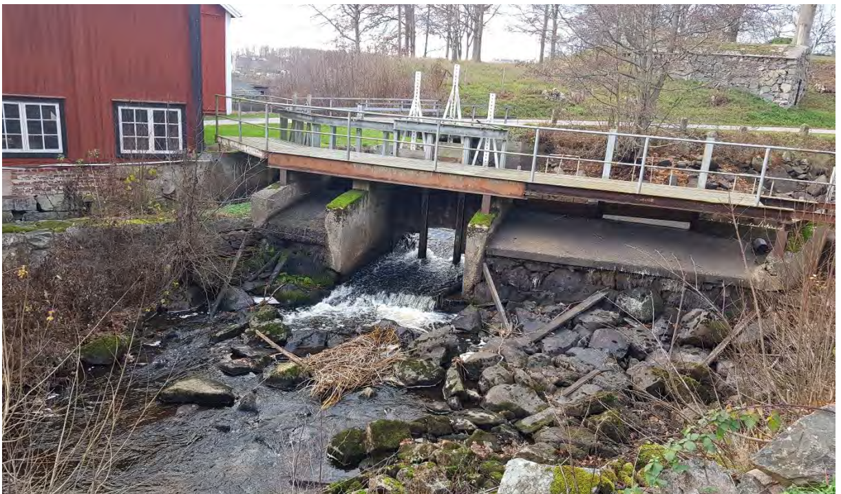
Figur 24. Den östra dammen vid Jannebergs kvarn i Mieån. Vid fototillfället var dammen öppen och allt vatten gick i spillfåran. Foto: Johan Andersson
