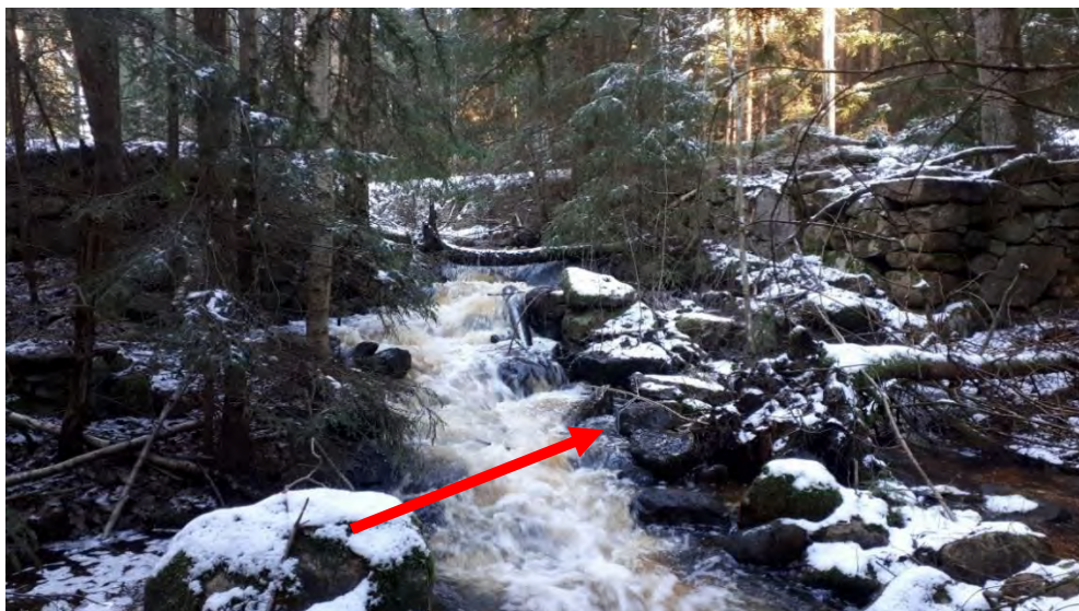
Figur 107. Delvis raserad kvarndamm utmed sträcka 24 i Påkamålabäcken. Röd pil: stenar som bör omfördelas så att fisk kan passera enkelt. Foto: Jonathan Bark
