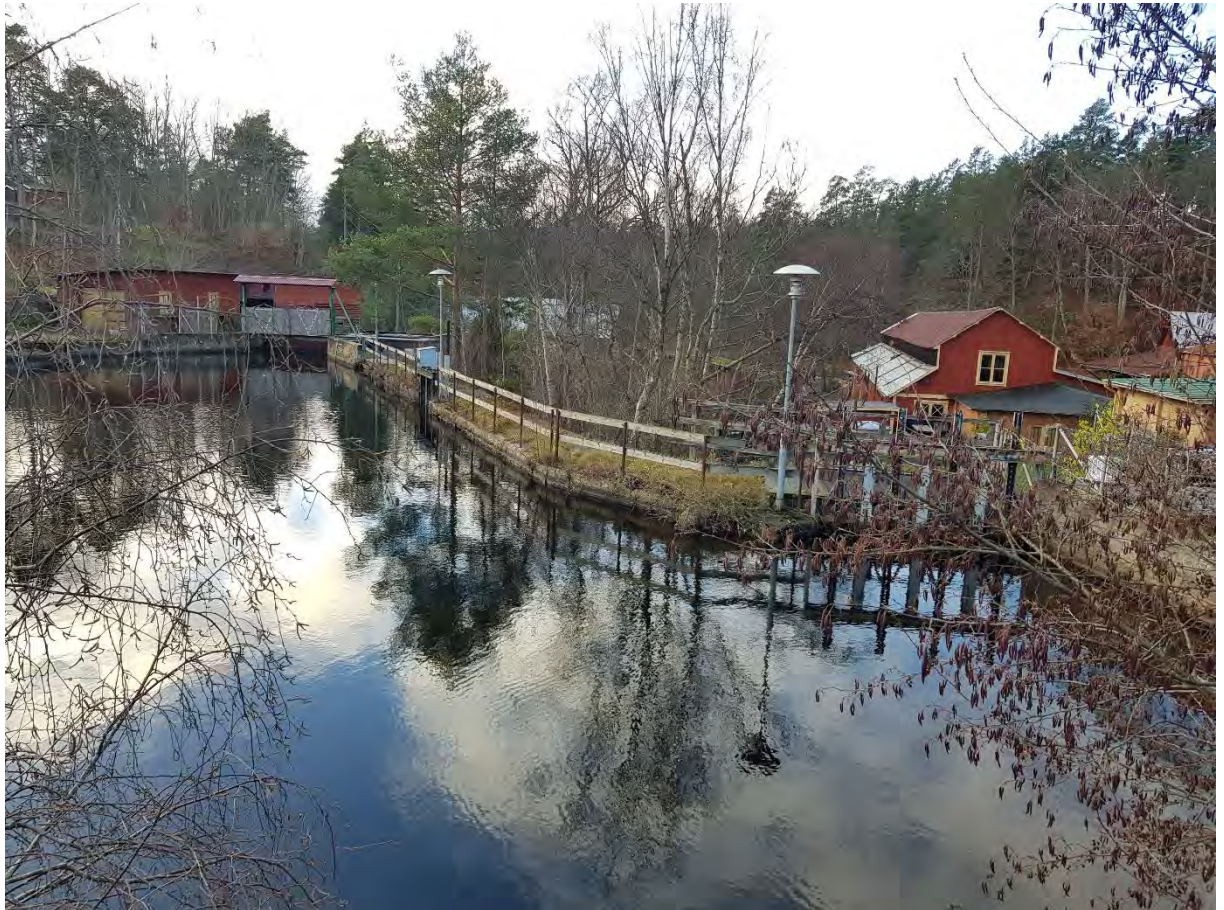
Figur 34. Dammen vid Granforsen bruk (övre) i Mieån. Intaget till kraftverket syns överst i vänstra bildkanten. Foto: Johan Andersson
