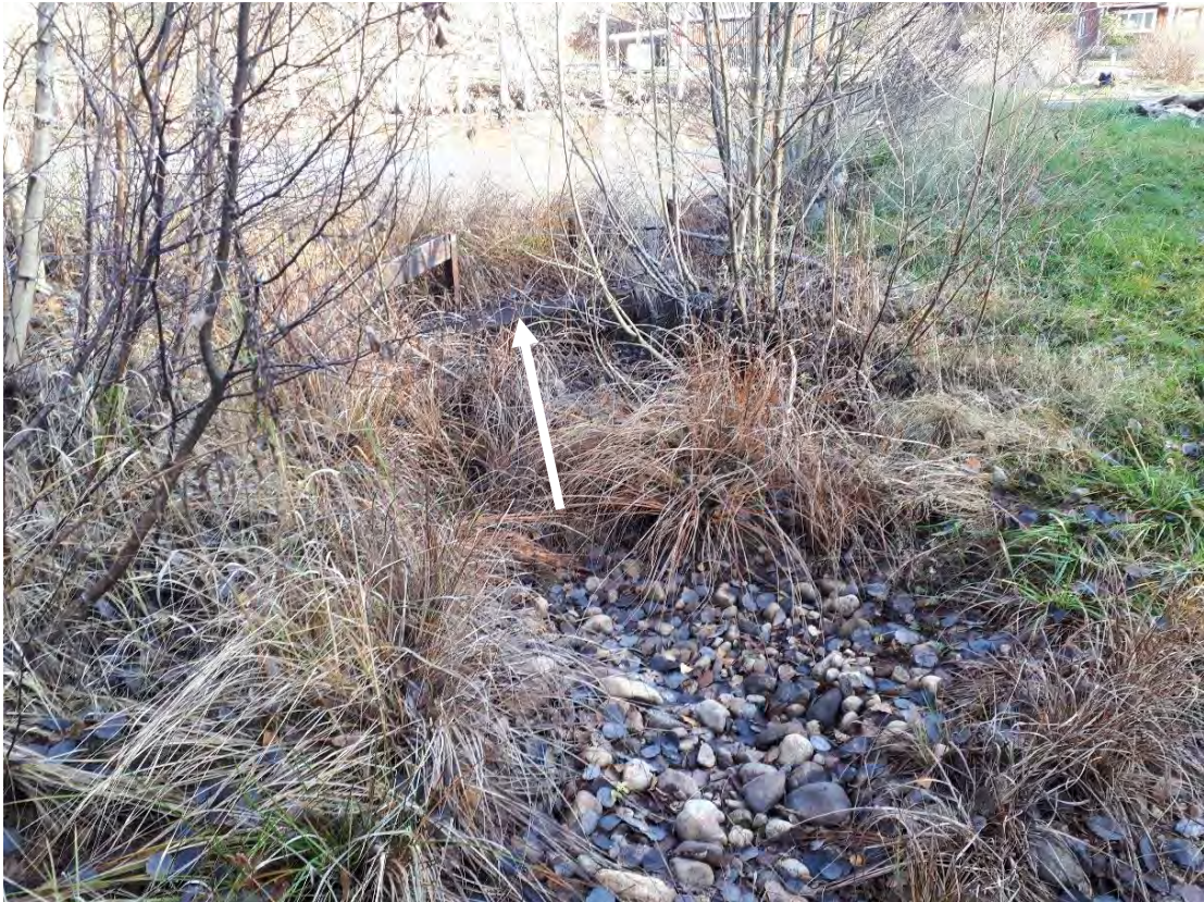
Figur 62. Överst i omlöpet runt Norrefors kvarn och såg i Mieån. Här har man stängt av omlöpet med betong (vit pil). Foto: Jonathan Bark
