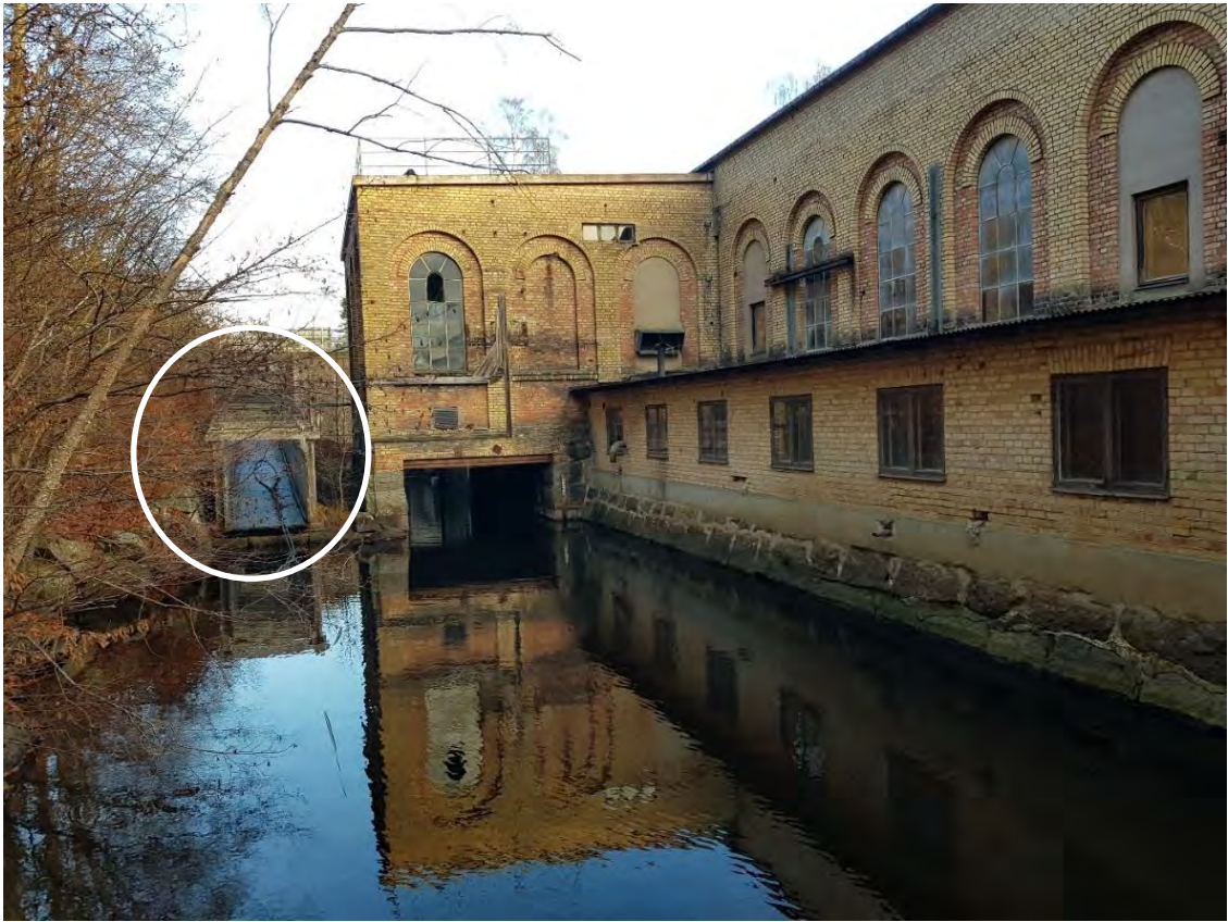
Figur 32. Granefors bruk (nedre) i Mieån, foto taget från nedströmssidan upp mot det avstängda kraftverket. Slitsrännan placeras där trärännan finns idag (inringad). Foto: Johan Andersson
