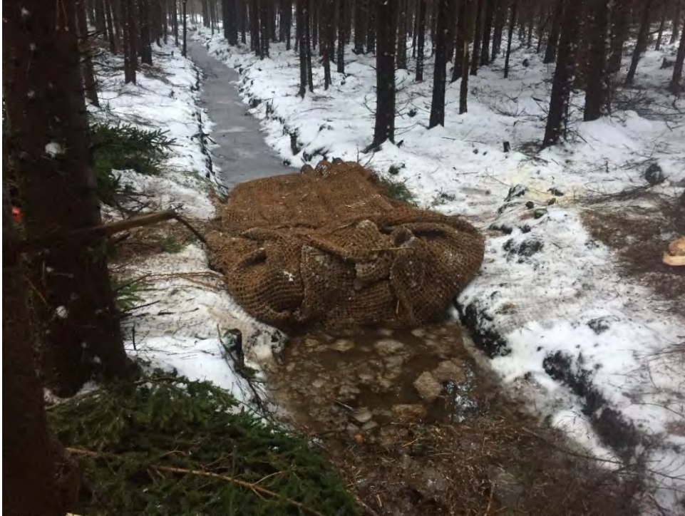
Figur 6. Material som används vid igenläggande av diken. Foto: Dan Calderon
