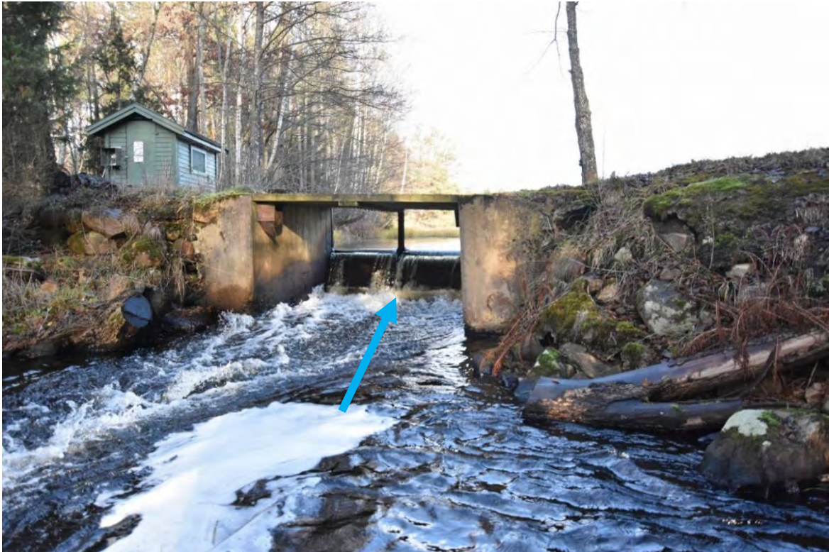
Figur 71. Den västra luckan genom dammen, Dannemarks kvarn och såg i Mieån. Foto: Jonathan Bark
