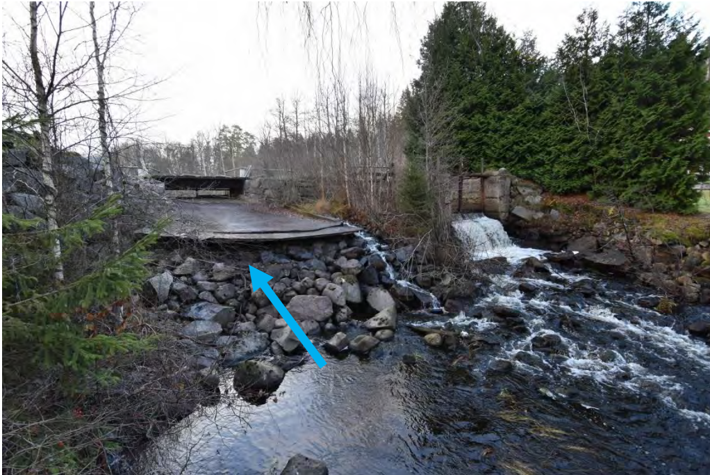
Figur 60. Norrefors kvarn och såg i Mieån, foto från nedströmssidan. Blå pil: den västra luckan. Foto: Jonathan Bark
