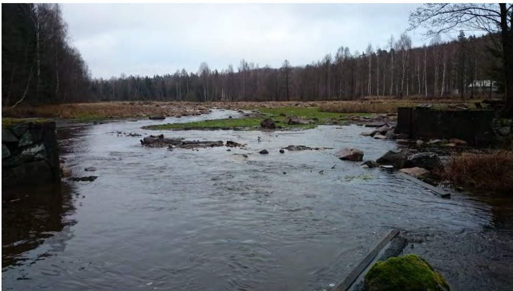
Figur 9. Dammen vid Hakafors i Mieån utriven, december 2014. Foto: Jönköpings Fiskeribiologi
