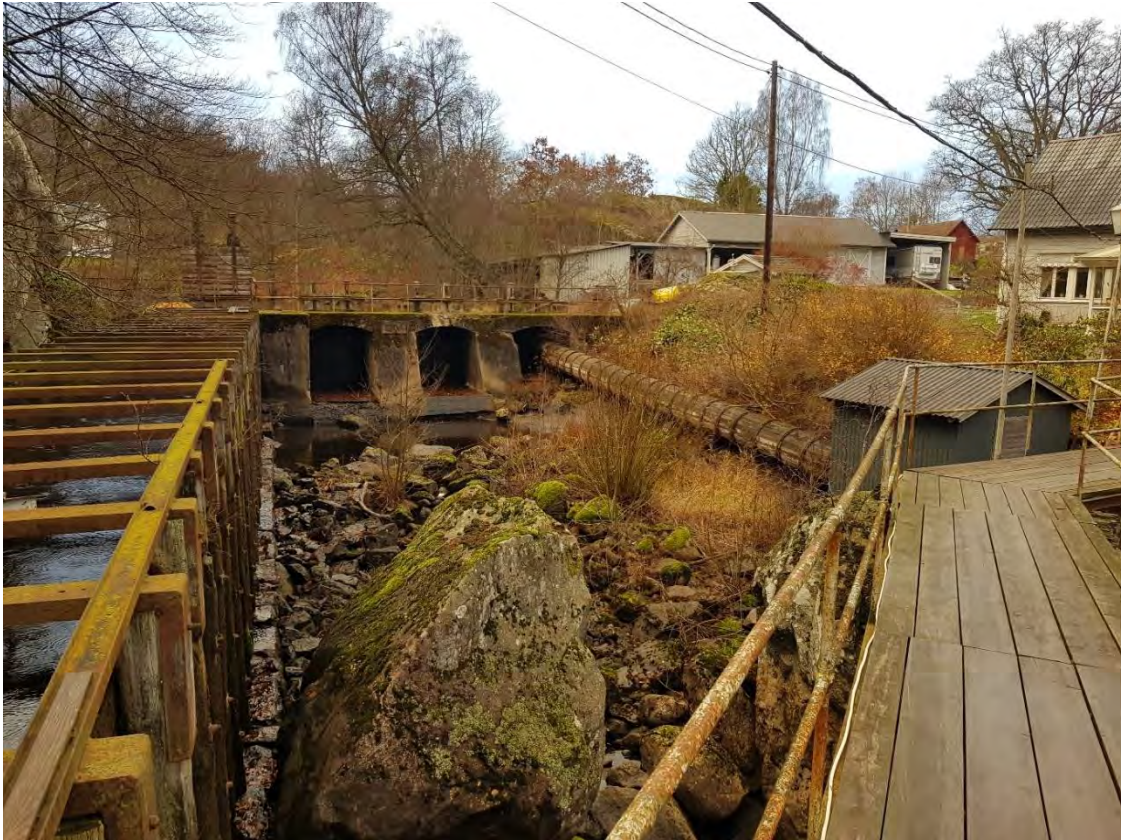
Figur 41. Nötabråne kraftstation i Mieån. Till vänster på bilden är intagskanalen till kraftverket. Anläggningen har också en mindre turbin i det gråa huset i torråran.
