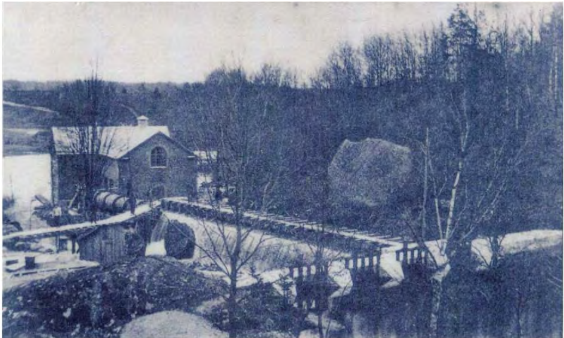
Figur 40. Nötabråne kraftstation i Mieån, i början av 1900-talet. Foto: Asarums hembygdsförening
